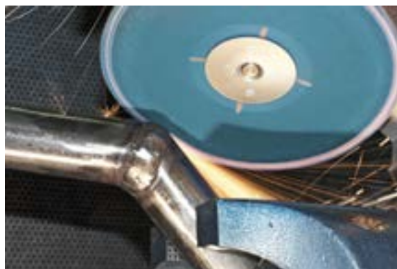
Lijado con una amoladora angular
